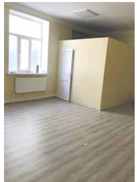
■ Neue Fenster, Heizkörper, Duschkabinen, Deckenbeleuchtung, verputzte Wände und Fußböden sind nun vorhanden
