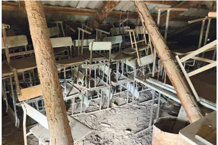
■ Die total verwurmtten Balken des Daches dieser Schule müssen erneuert werden.
