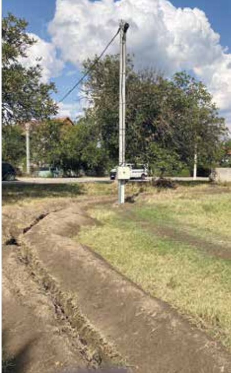
■ Noch müssen die Gräben zugeschüttet werden. Die Wasserleitungen sind jedoch fertig verlegt, auch Strom ist vorhanden.
