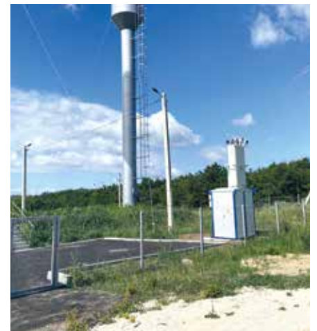
■ Das vergangene Wasserprojekt in Oliscani Bild: Pro Humanitate
