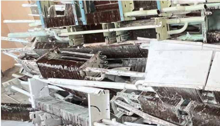
■ Die demontierten Heizkörper mit Leitungsrohren der Schule George Enescu in Calarasi
