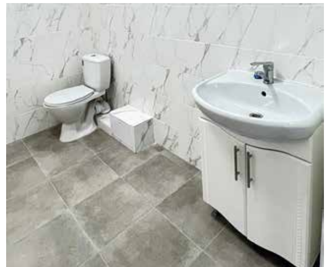
■ Die Sanitäreinrichtungen der Tagesklinik Calarasi.
