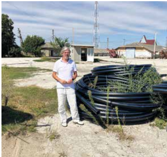
■ Christian Degen, unser neuer stellvertretender Vorsitzende, bei der Besichtigung der Baustelle Wasserprojekt Petrunea
