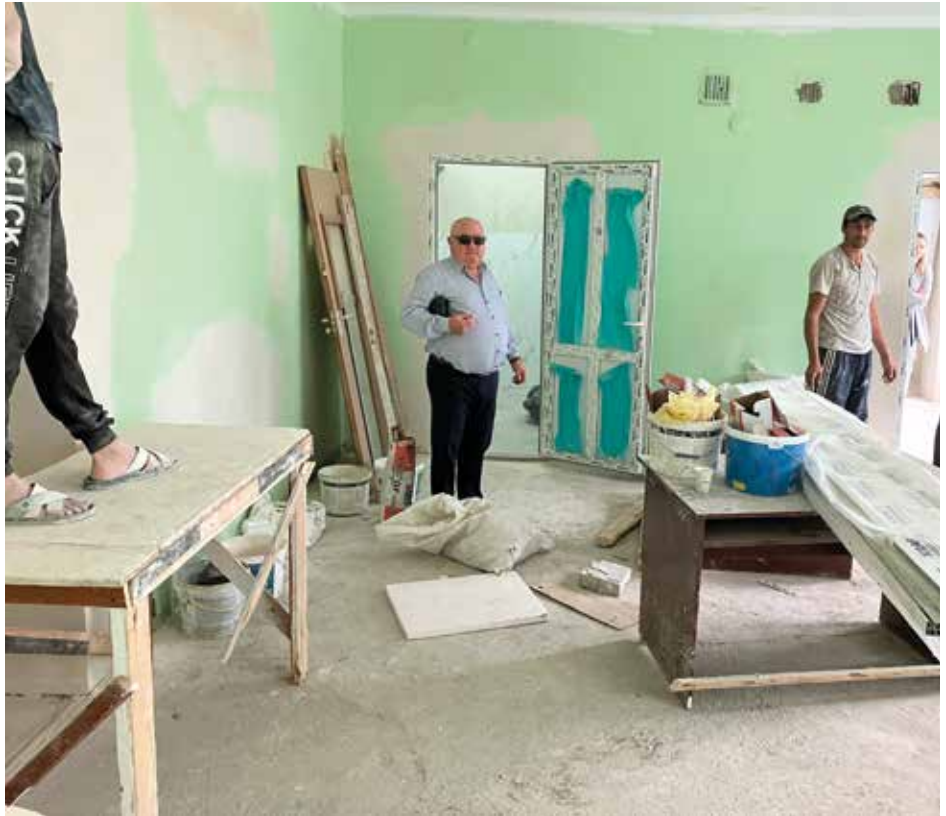
■ Die Firma Lozval-Construct bei der Renovation der Tagesklinik in Calarasi.
