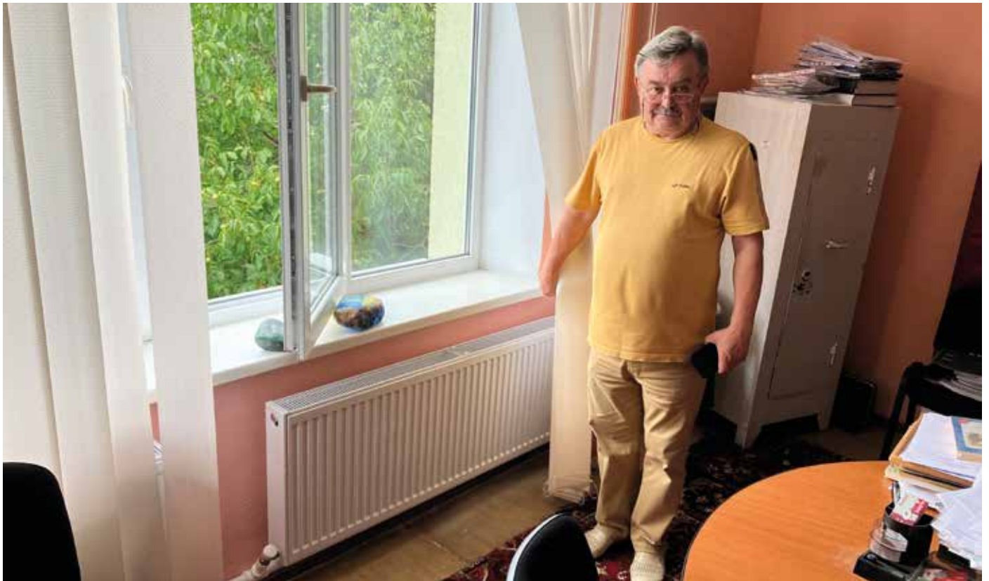
■ Stolz präsentiert uns der Direktor dieser Schule die neuen Heizkörper.
