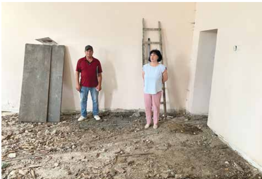
■ v.r.n.l Die Bürgermeisterin von Cobilea, Frau Angela Ababei, mit dem Bauingenieur bei Beginn der Bauarbeiten des Altenheimes in Cobilea Bilder: Pro Humanitate
