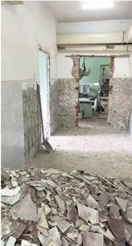
■ Dieses Bild entstand zu Beginn unserer Renovationsarbeiten in der Tagesklinik Calarasi
